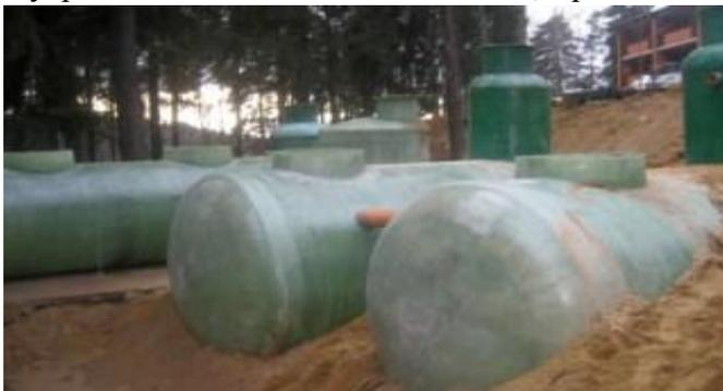
Септик обладает повышенной прочностью, так как изготавливается из армированного стеклопластика методом машинной намотки (не ручная клейка) и имеет очень высокую устойчивость к деформации при давлении или сжатии.
