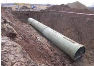
**Трубы** из стеклопластика производятся методом машинной намотки (навивки). Трубы из стеклопластика прочны, долговечны. Стеклопластиковые трубы широко применяется для нужд ЖКХ, в системах напорных и безнапорных сетей промышленной, ливневой канализации. Трубы стеклопластиковые имеют отличные эксплуатационные характеристики.
